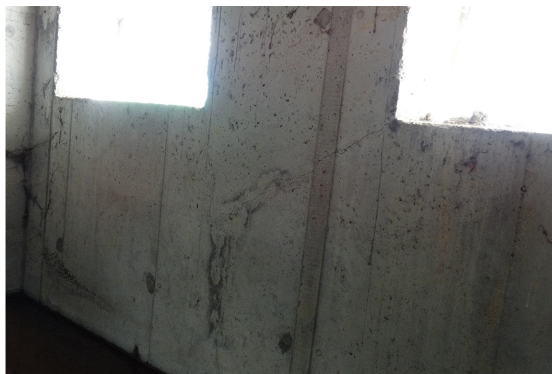
Fot.4,5,6 Rysy w ścianach fundamentowych
