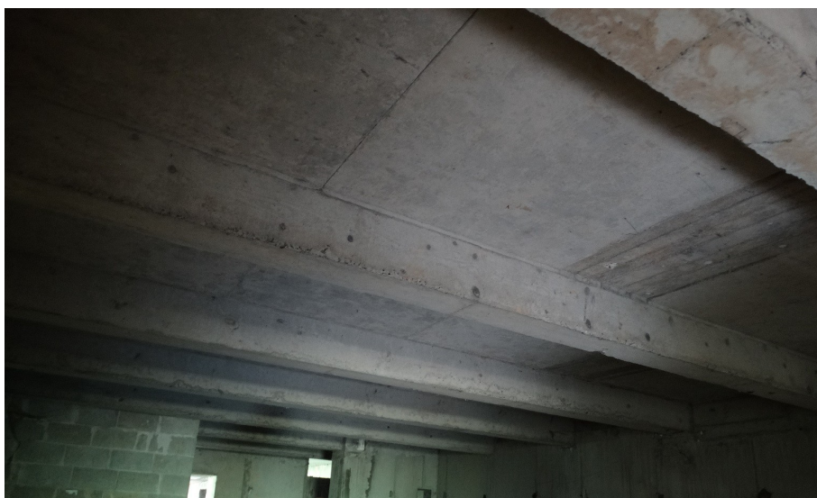
Fot.2. Strop płytowo-żebrowy (od spodu)
