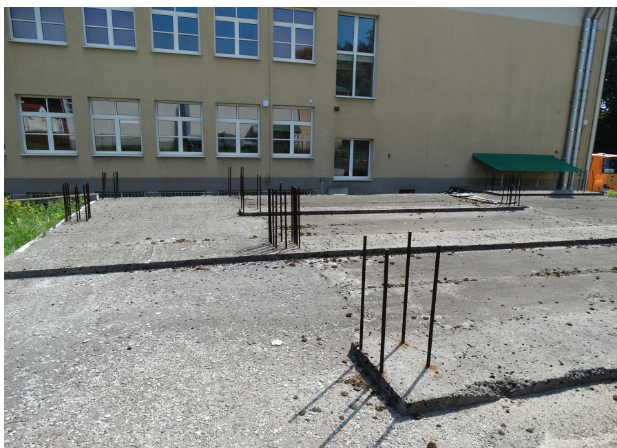
Fot.3. Fragment Stropu płytowo-żebrowego (od góry)
