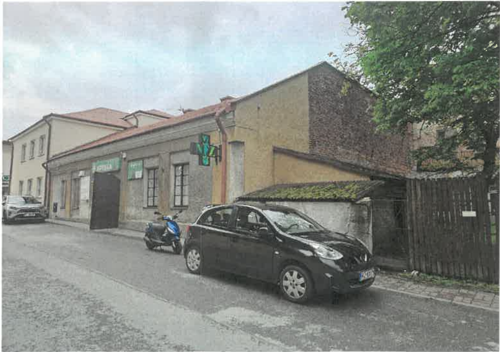
WIDOK NA FRAGMENT ELEWACJI WSCHODNIEJ
