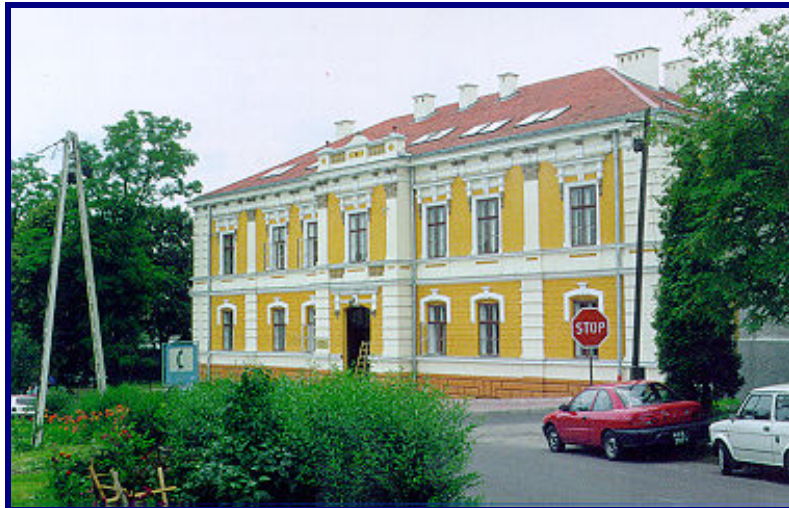
Zdjęcie 4. Budynek WSSG w Tyczynie
