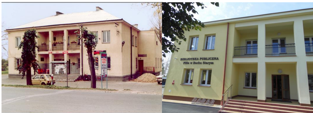
Fot. 2,3. Budynek Domu Ludowego w Borku Starym przed remontem (z lewej) i po remoncie (z prawej).
